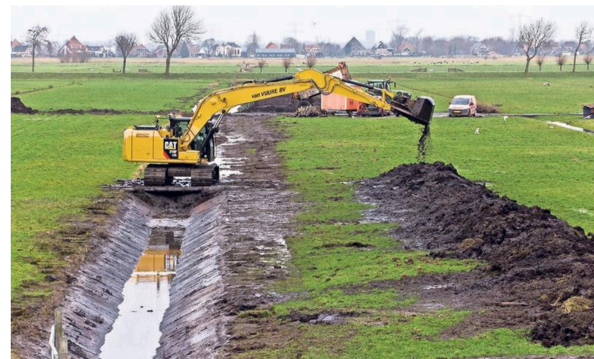
Het graafwerk is in volle gang.
